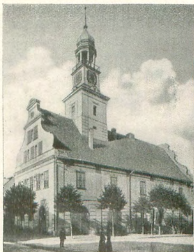
Das Rathaus, Südostansicht im Zustand zwischen 1797 u. 1920. Aufnahme um 1915.
