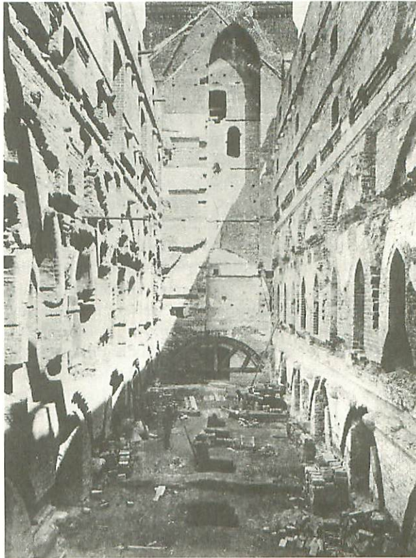
Abb. 5: Das Innere des Ostflügels des Hochschlosses am Anfang der Rekonstruktion der Gewölbe, 1888 (BAUJAHR 1888, Abb. 36)
