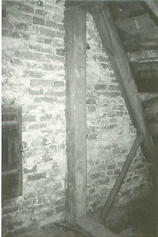
Abb. 14: Wormditt. Pfarrkirche St. Johannes Ev., Dachwerk (11) über dem südlichen Seitenschiff, Mauerwerk des Südgiebels, das um die bestehende Holzsäule hochgezogen und an anderen Holzelementen mit Zugankern aus Eisen befestigt wurde. (Fot. A. KONIECZNY)
