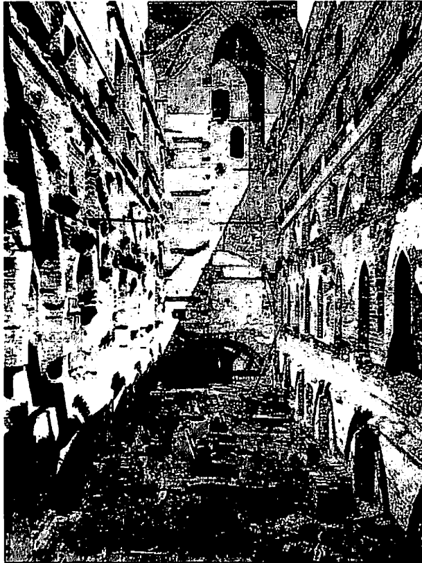
Abb. 5: Das Innere des Ostflügels des Hochschlusses am Anfang der Rekonstruktion der Gewölbe, 1888 (BAUJAHR 1888, Abb. 36)
