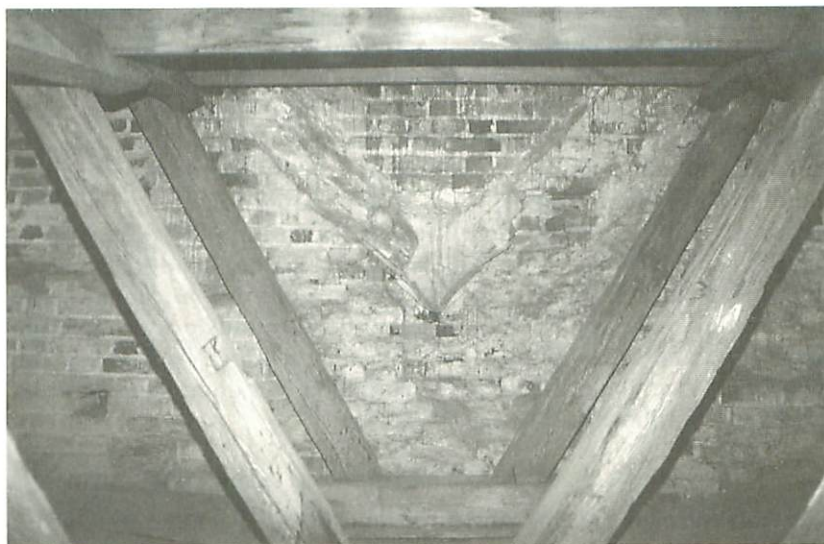
Abb. 7: Wormditt. Pfarrkirche St. Johannes Ev., Südwand des Hochschiffes im Dachraum über dem südlichen Seitenschiff. Dachwerke (10, 11) mit deutlichen Spuren einer älteren Dachkonstruktion. (Fot. A. KONIECZNY)
